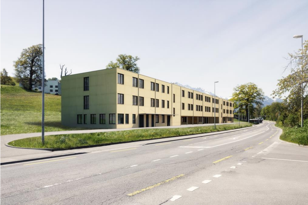
Sicht von der Oberschachenstrasse
